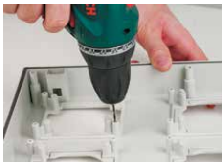
Розетка устанавливается на новые посадочные места. Так как по умолчанию с лицевой стороны данные отверстия заблокированы, то для удобства установки необходимо сделать сквозные отверстия сверлом 3 мм. Отверстия не нужно делать, если устанавливается розетка с фланцем 70x87 мм, например, DIS5706407
