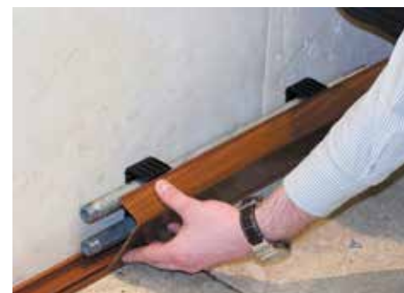
Система закрывается декоративной крышкой
