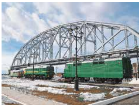
Объекты инфраструктуры Мосты, тоннели, конструкции с малым количеством опор
