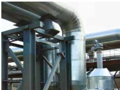
Городское и муниципальное строительство Уличные опоры инженерных коммуникаций
