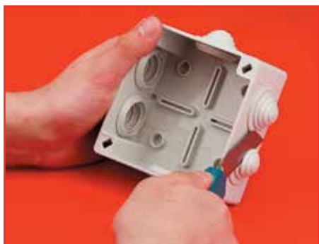
1 этап. Срезаем кабельный ввод
