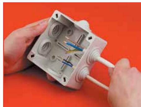
3 этап. Ввод кабеля
