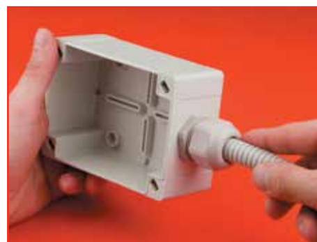
3 этап. Осуществляем ввод трубы и кабель
