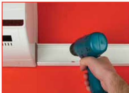
Закрепите основание короба на стене
