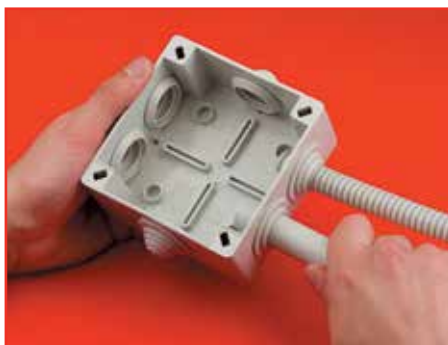
2 этап. Ввод гофрированной и жесткой трубы
